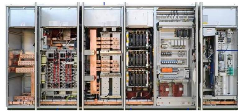
**3L-NPC Umrichter: 3,3kV, 1600A, 9MVA, wassergekühlt (ABB ACS6000)**
